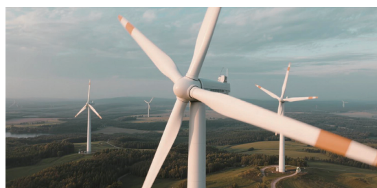
风电〈变桨〉 Wind Mill
